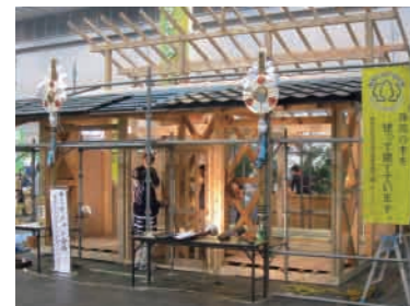
■大工組合による地域材を使用した上棟風景
