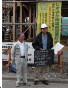
■取材協力に応じて頂いた野村邸建築現場
