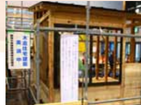
木造住宅建築の実演。震災時の仮設住宅としても期待ができる。
