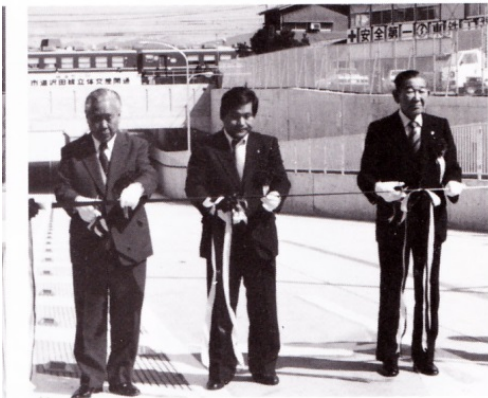
㊦ 幟道ガード完成
