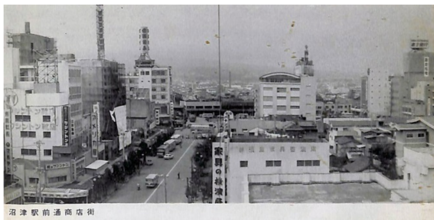
↑丸井ビル建設中
