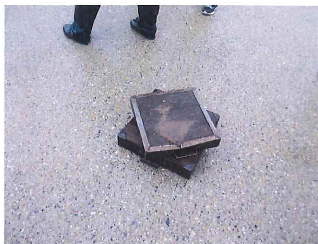
ジャッキベースの重ね方
