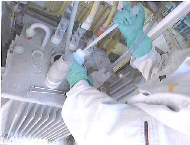
機器内絶縁油の分析用試料採取(例:トランス)
