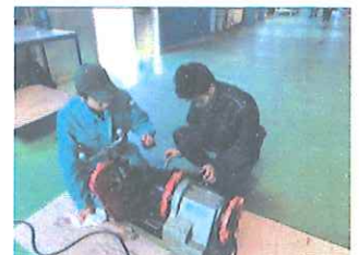
設備技術科 鋼管、塩ビ管を使用した配管工事実習
