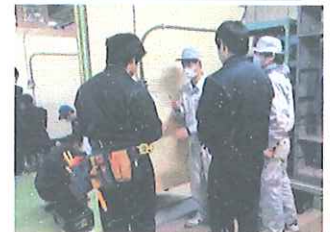
電気技術科 照明、スイッチを使用した電気配線実習
