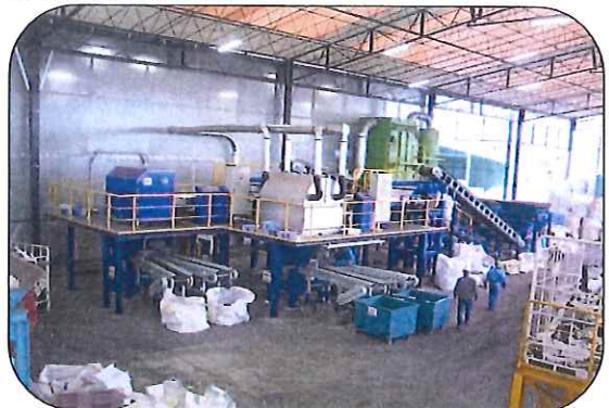
非鉄金属の選別設備
