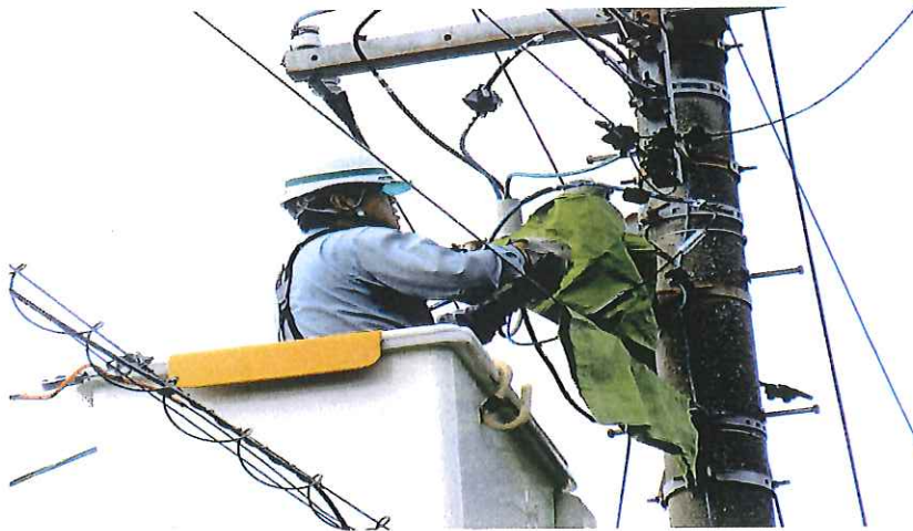
00ヤ692 感電防止低圧シートを活用して作業に入る。
