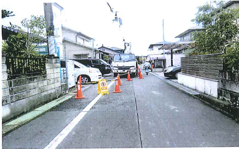
作業範囲をカラーコーン・コーンバーで囲み看板取付
