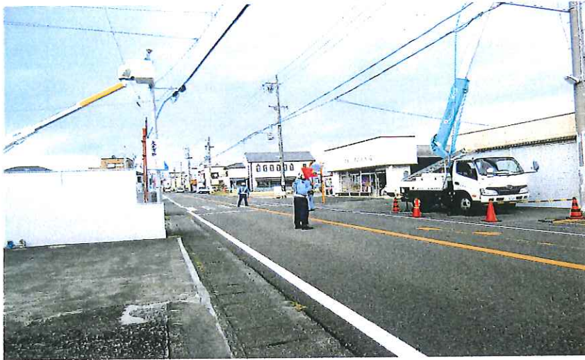
63サ672 道路横断工事監督者の合図とともに警備員が通行止めに入る。
