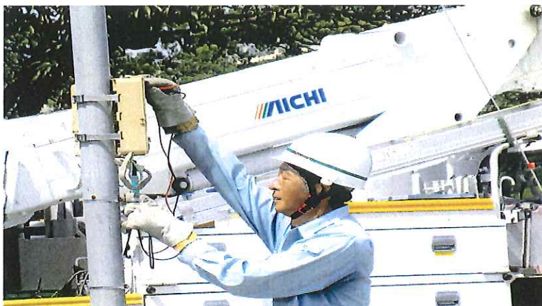
57ミ665 安全マスクを使用して通電確認をして下さい。
