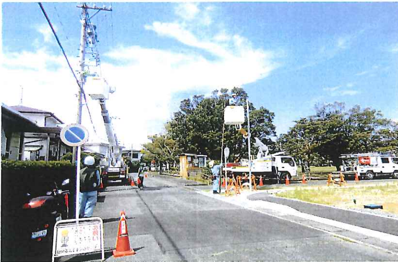
57ミ665 道路横断工事、相互連携を取りながら作業を行う。
