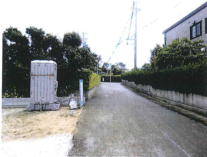
67ラ581 電線の垂れ下がり
