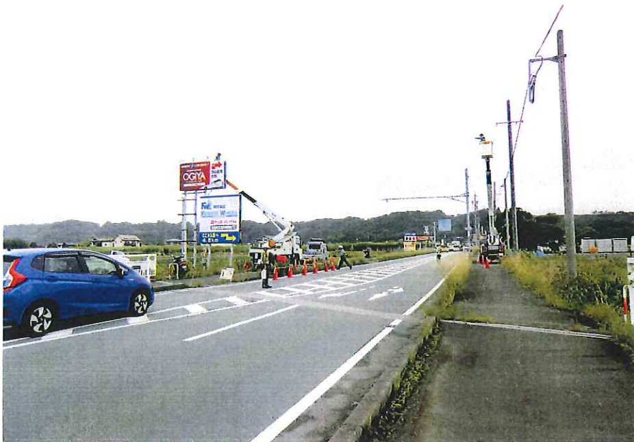
電線を取付作業で両サイド交通を止めて電線を延線作業。
