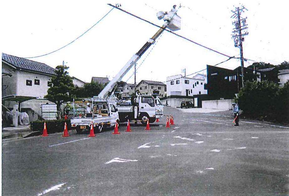
変則3差路での延線工事警備員と連携を取りながらの作業
