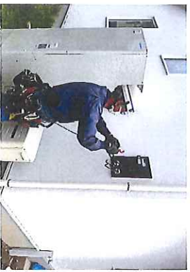
【OK】 計器取付時には工具、計器等を地面に直接置かず作業してました。
