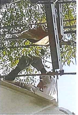
【OK】 充電部作業の絶縁シート
