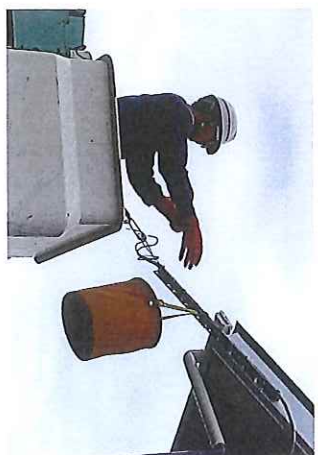
【OK】 作業前の検電 【OK】 防具の使用(引込支持点)
