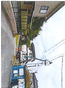
【6/25指摘事項 お客様建物・その他建物等に傷をつける等の有害性】 次の通り、注意を払った作業をしていました。 ・作業場所にゴミ置き場等があり、作業時に接触の可能性がありましたが接触しないよう注意作業しました。 ・建物側の接続時には余ったDV電線をネット内に引き入れ、お客様建物に傷がつかないように作業しました。
