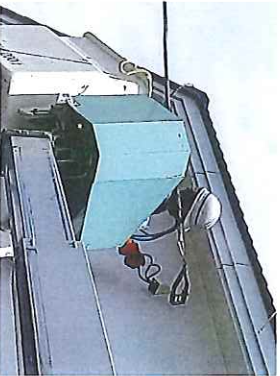
【6/25指摘事項 お客様建物・その他建物等に傷をつける等の有害性】 次の通り、注意を払った作業をしていました。 ・作業場所にゴミ置き場等があり、作業時に接触の可能性がありましたが接触しないよう注意作業しました。 ・建物側の接続時には余ったDV電線をネット内に引き入れ、お客様建物に傷がつかないように作業しました。
