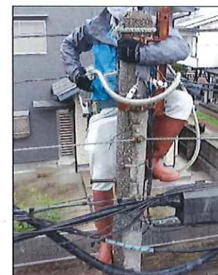
被災時の状況（作業イメージ）
