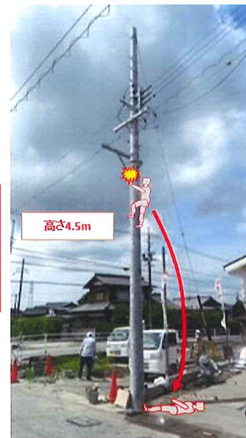
被災時の状況（作業イメージ）
