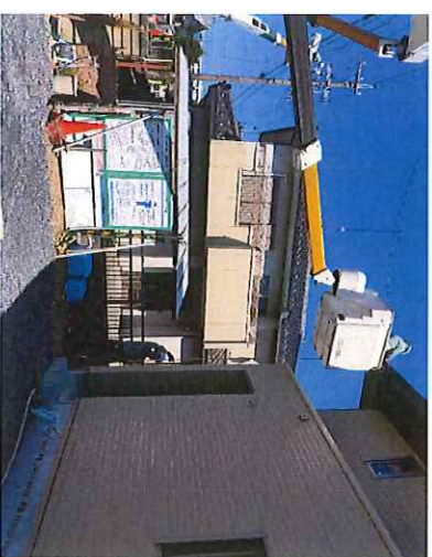
【OK】高所作業車の接地、接地線でのつまき防止、輪留め、アラトリガーは全車に保護ゴム付
