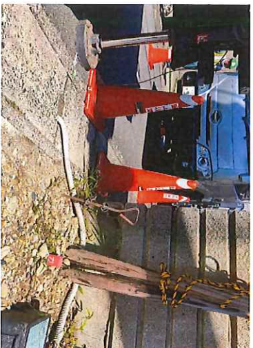
【OK】高所作業車の接地、接地線でのつまき防止、輪留め、アラトリガーは全車に保護ゴム付
