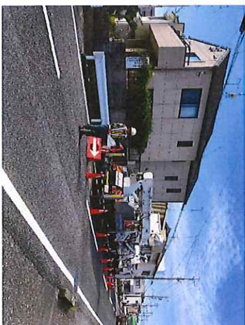
【OK】ヒートショック・バーで充分に囲い、安全帯域、誘導員配置
