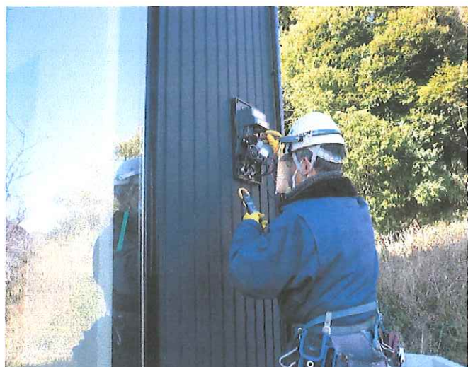
送電後 電圧確認 防護具着用
