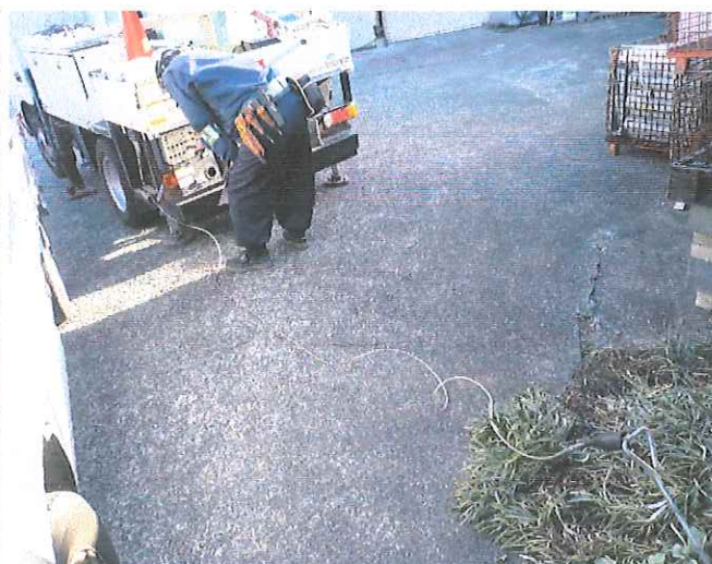
高所作業車のアースの設置の様子
