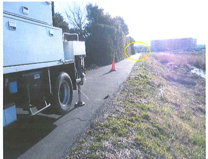
交通誘導員の配置 黄色○印箇所
