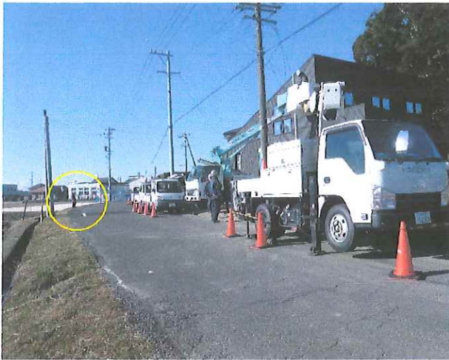
セーフティコーンによる作業区画の確保 誘導員の配置 黄色○印箇所
