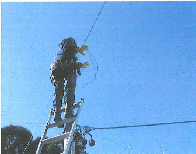
活線の為、絶縁手袋着用にて作業する
