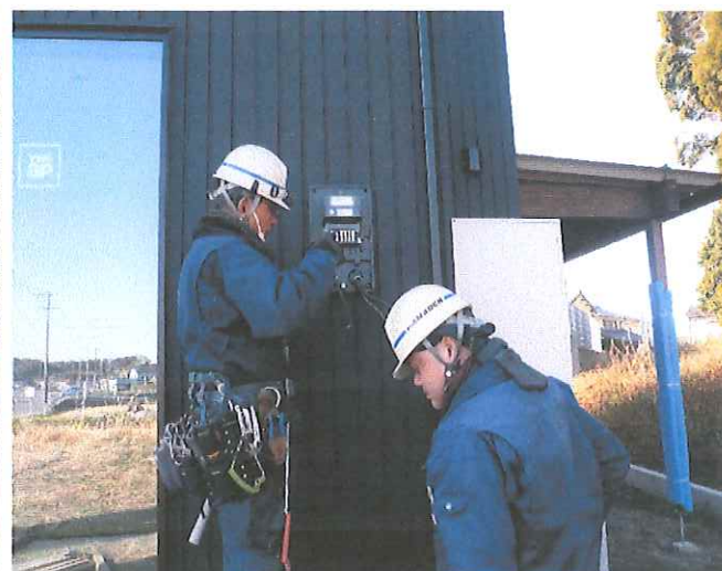
送電前計器取付け 責任者と計器番号の確認
