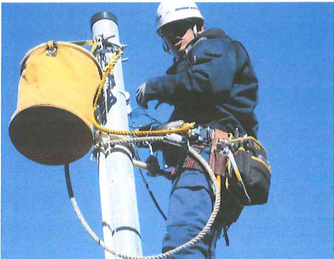
ハーネス着用 ランヤード使用にて作業
