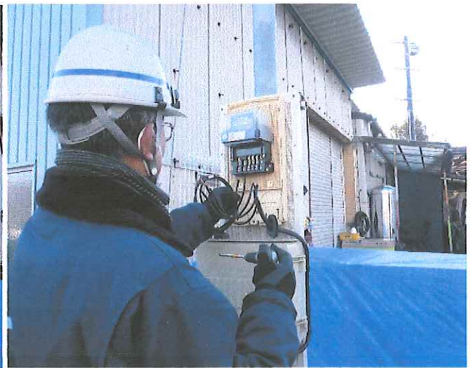
送電前の計器 中性線より電線の挿入
