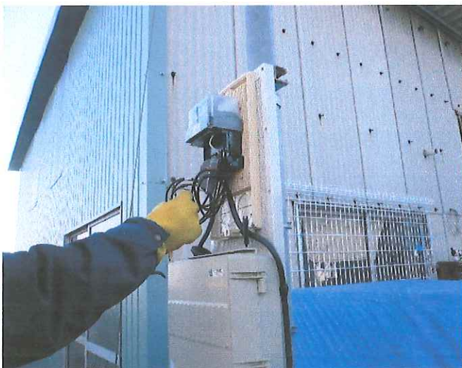
送電前の計器取付けの様子
