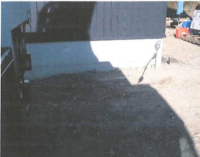
高所作業車のアースの設置の様子
