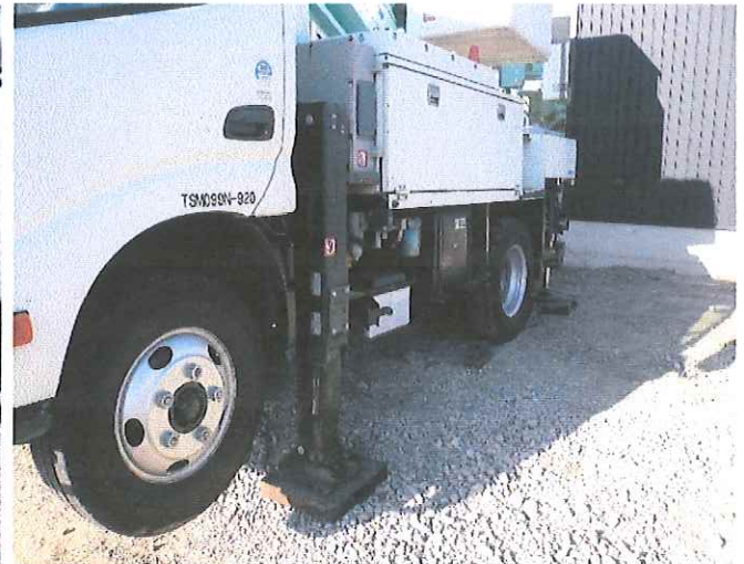
高所作業車の輪止め設置の様子
