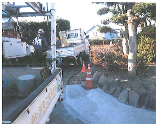
未舗装部分の区画確保
