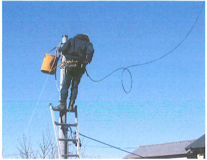
引込線のたるみ改修
