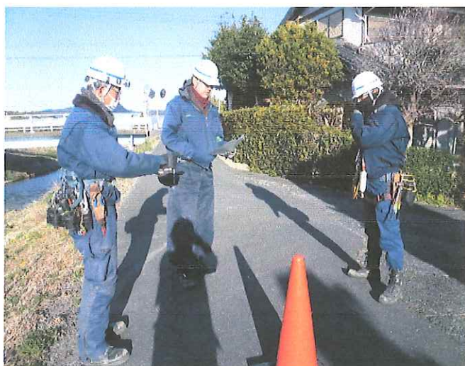
作業前 TBM/KYの様子 作業責任者の腕章確認
