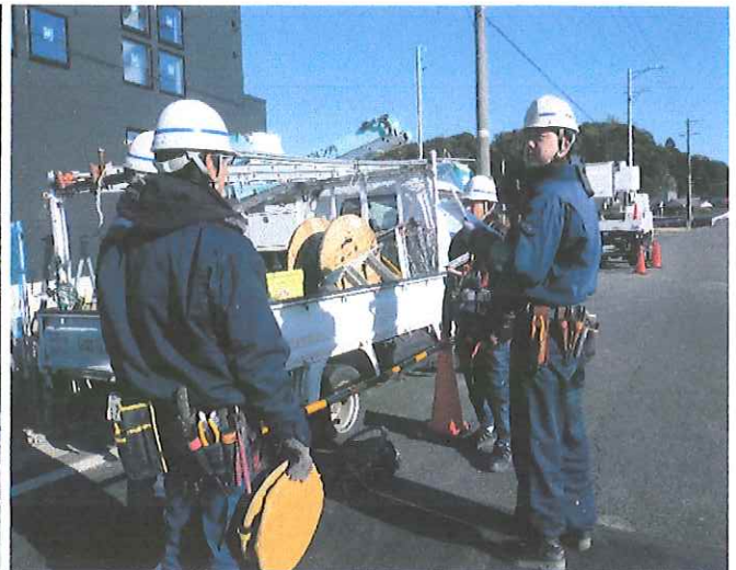
作業前のTBM/KYの様子
