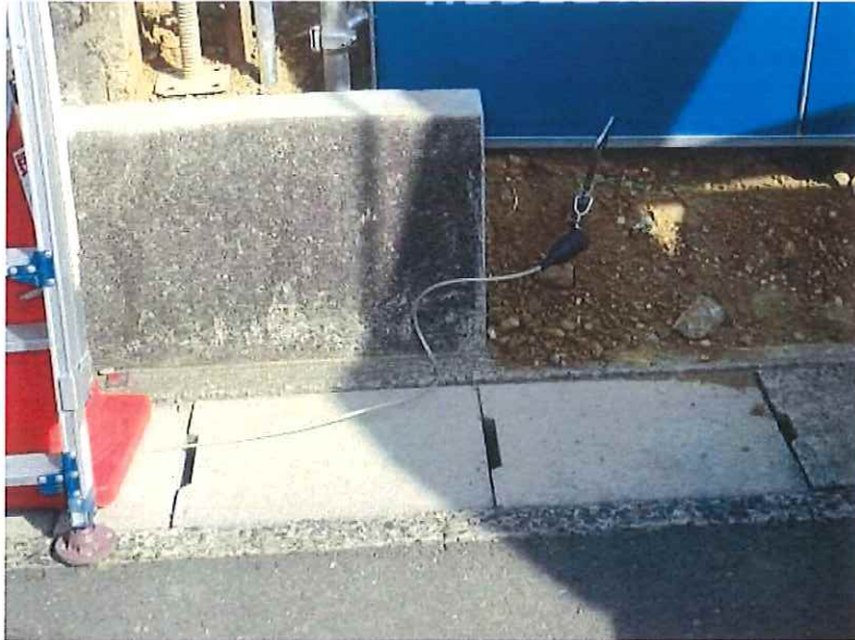
高所作業車車体アース設置状況
