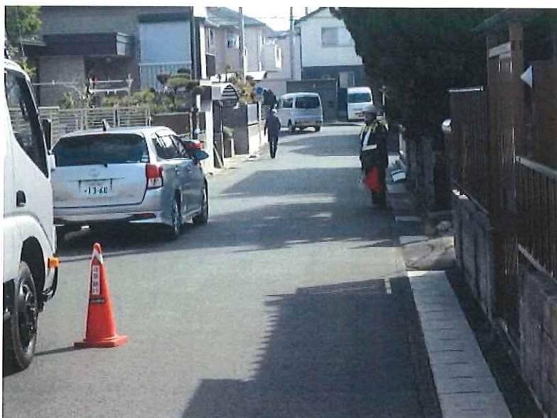
交通誘導員配置状況
