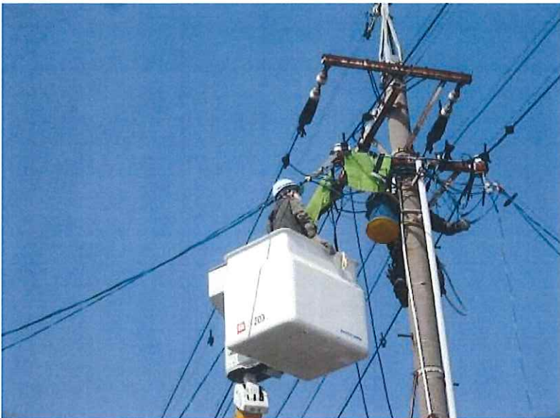
引込柱 低圧シート取付状況
