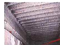
アスベスト含有吹付け ロックウール (鉄骨材の耐火被覆)
