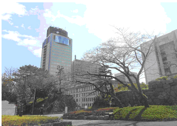
（静岡県庁舎） 静岡県消防設備保守点検業協同組合は、受注に向けて組合員が共同で点検技術や点検体制等の努力を積み重ね共同受注を実現しています。
