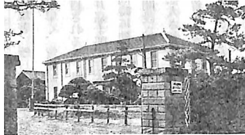
石橋沼津製糸工場、工場正門、事務所
