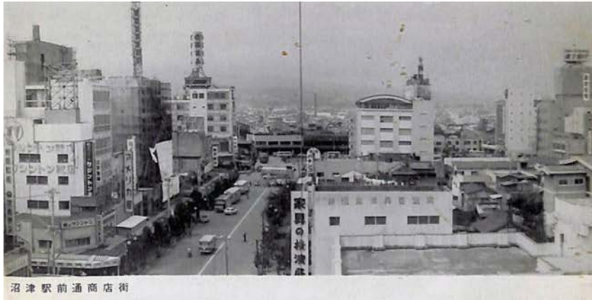
↑ 丸井ビル建設中
