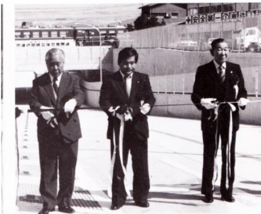
▲ 幟道ガード完成
