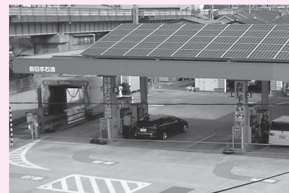
▲防災拠点としての期待が高まる災害対応型給油所
