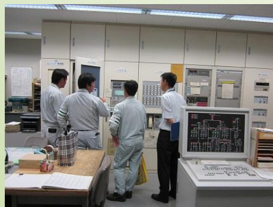
▲東館地下 1 階監視室
