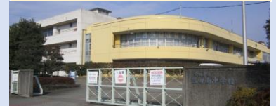
浜松市立豊田南中学校 点検組合員：豊田消防設備
